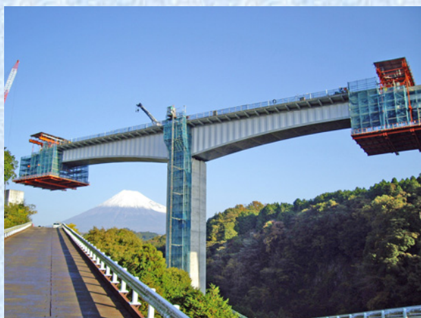
張出し架設状況
