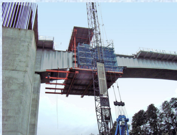
波形鋼板支保工による施工
