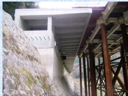
第1回施工端部
