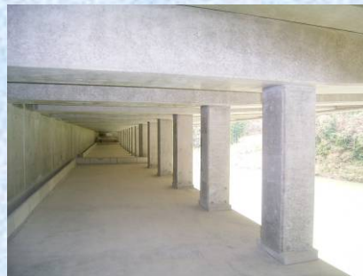
擁壁構造内部
