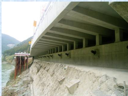
第1回工事完成
