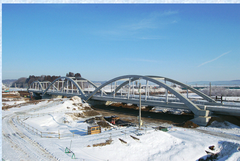
天間川橋梁 (青森県上北郡 JR 東北本線)
