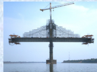
斜版部張出し架設
