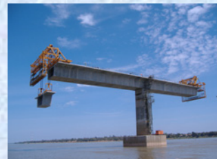
プレキャストセグメント張出し架設
