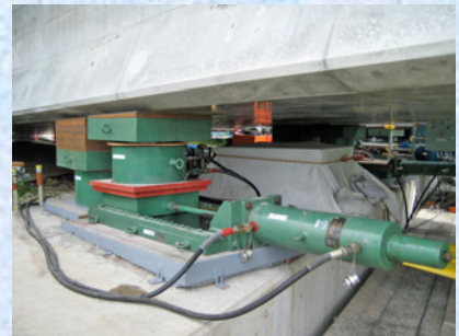
ARC工法押し出し装置
