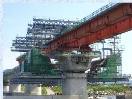
架設作業車の中間橋脚部通過
