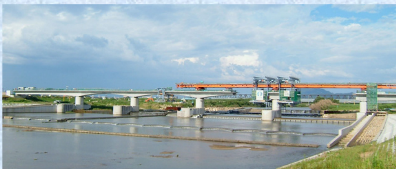
架設桁併用張出し架設全景
