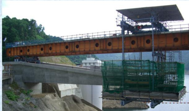
架設桁併用張出し架設
