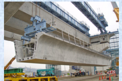
U桁架設吊上げ状況
