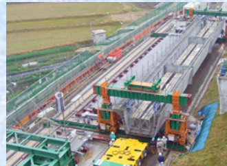
U桁製作運搬状況
