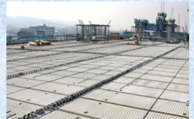
床版 PC板架設状況
