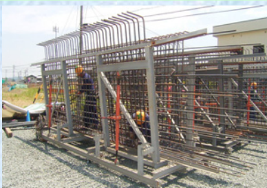
鉄筋のプレファブ化
