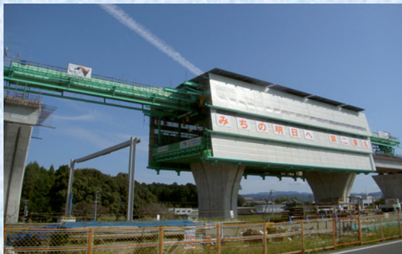
大型移動支保工による架設
