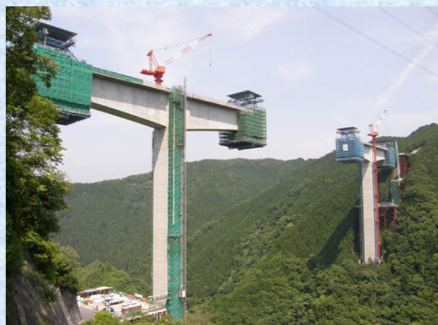
張出し架設状況
