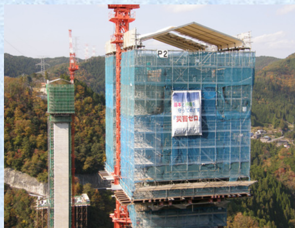
柱頭部施工状況
