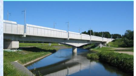
七戸川Bは東北新幹線（八戸・新青森間）のうち、八戸から北へ33kmの青森県上北郡東北町と七戸町にまたがる延長1,244m（橋梁1,044m、路盤200m）の工事のうち、一級河川高瀬川（七戸川）を渡河する橋長136m（支間長67.1m）のPC2径間連続ラーメン箱桁橋です。
