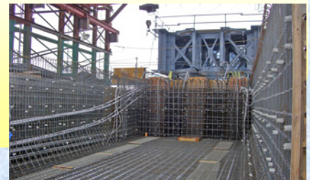
主桁製作架台
