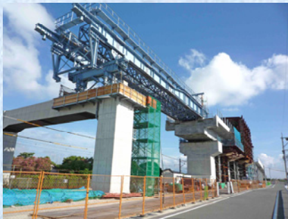
手延べ桁及び主桁製作ヤード
