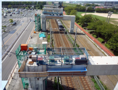
門型ラーメン橋脚及び押し出し装置
