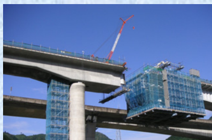
2主版桁と箱桁の連続部(P7)
