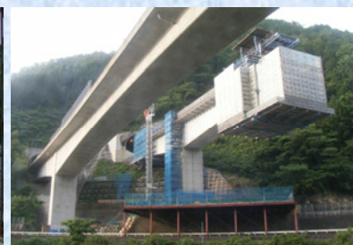
P9張出し異種架設作業車
