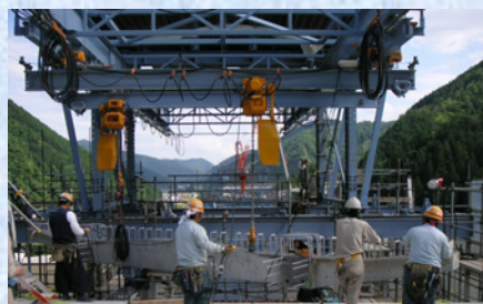
Rap-con工法で「プレキャストリブ」架設
