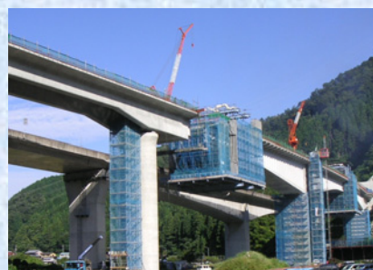
波形鋼板ウェブ箱桁橋
