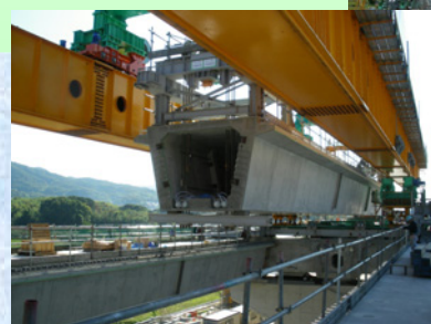
ガーダーに吊り替え
