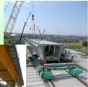
既設桁上での接合・組立
