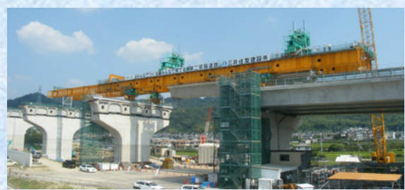
ガーダー架設全景
