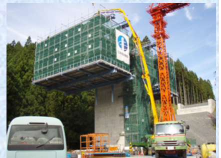
コンクリート打設
