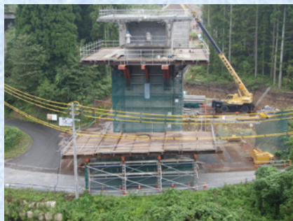
道路防護対策
