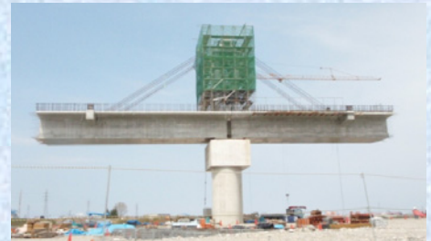
5P 側径間斜吊り状況
