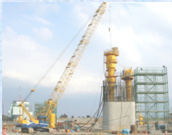
橋脚ケーソン施工状況
