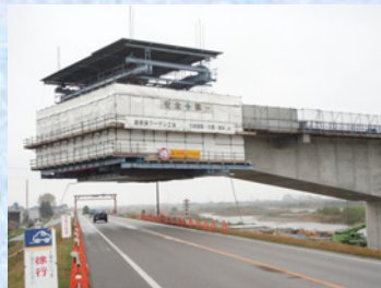
超低床ワーゲンによる架設状況
