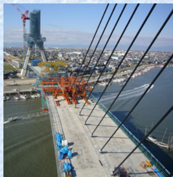
広幅員曲線橋
