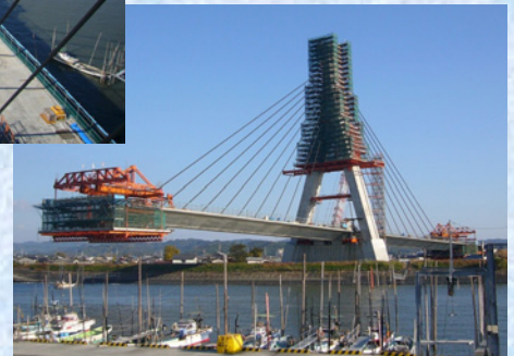
主桁張出し架設
