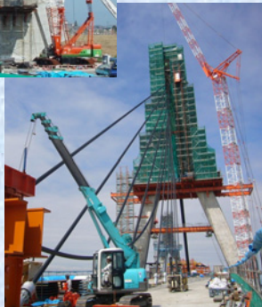
斜材保護管架設
