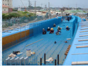
④下床版ウレフ配筋
