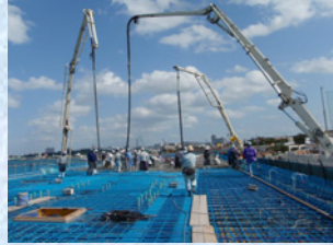
⑦上床版打設
