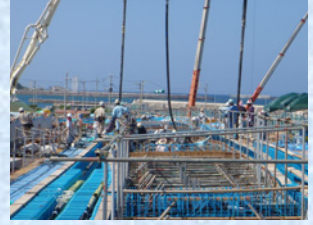
⑤下床版ウレフ打設
