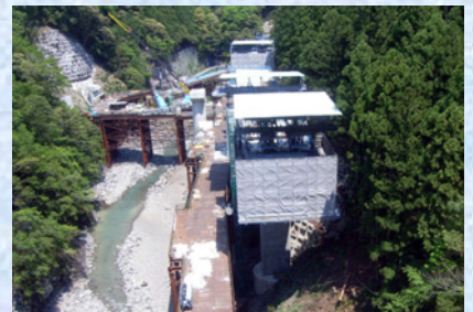
A1 から架設全景
