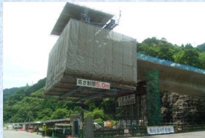
P3 張出し架設状況(仮支柱使用)
