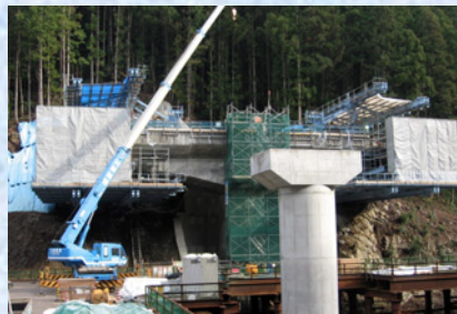
P2 分岐部張出し架設状況
