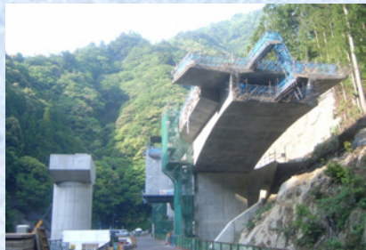
P2 分岐部中空床版橋施工予定部
