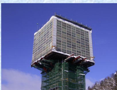
柱頭部支保工架設
