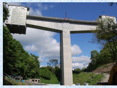
張出し架設全景
