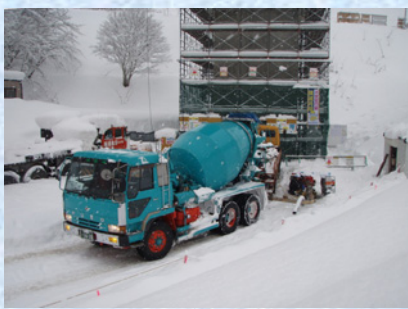
冬期積雪時施工状況
