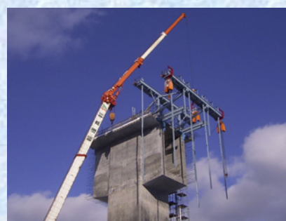
移動作業車組立
