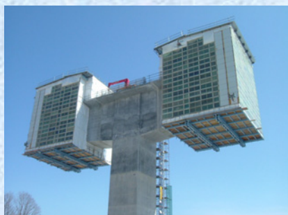
冬期張出し架設状況
