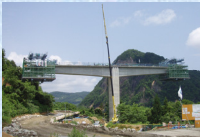
P1 張出し架設状況
