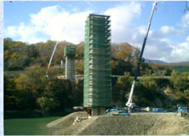
橋脚施工状況
