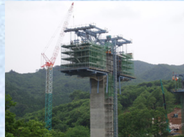
P2 張出し架設状況
