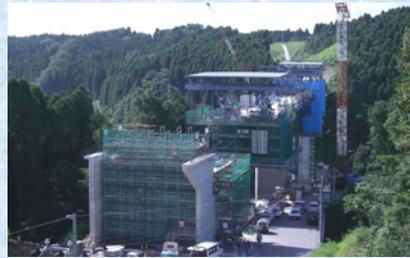
橋台パラペット及び側径間支保工架設
