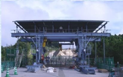
波形ウェブ対応型移動作業車
