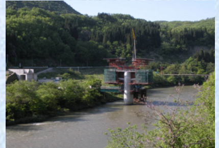
移動作業車組立状況
