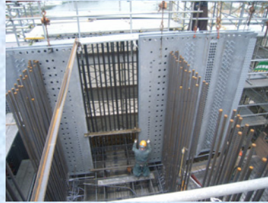
柱頭部波形据付状況
