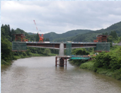
張出し架設状況
