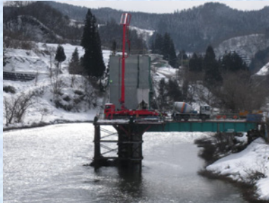
橋脚頭部施工状況
