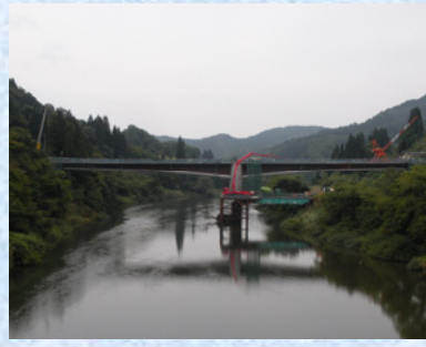
側径間吊支保工部施工状況
