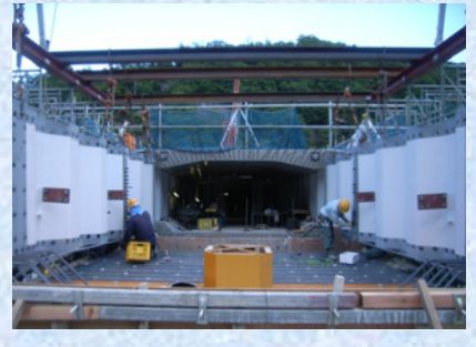
側径間第1リフト施工状況
