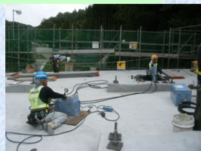
P1 仮固定緊張工
