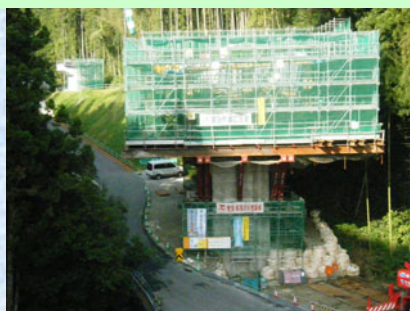
P1 柱頭部工
