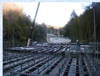
P2-A2 支保工架設状況
