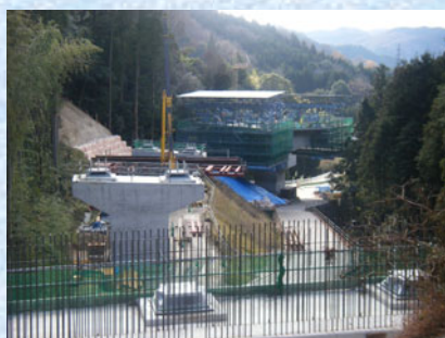
P1 張出し架設状況
