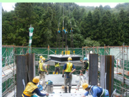
P1 支承設置及び仮固定配置
