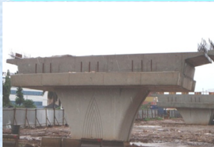
橋脚及び橋脚頭部
