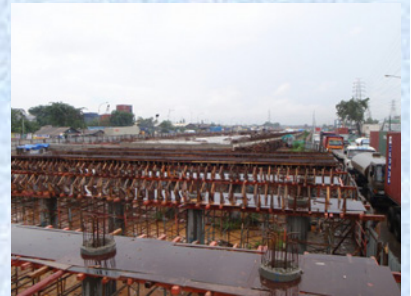
パイルスラブ区間
