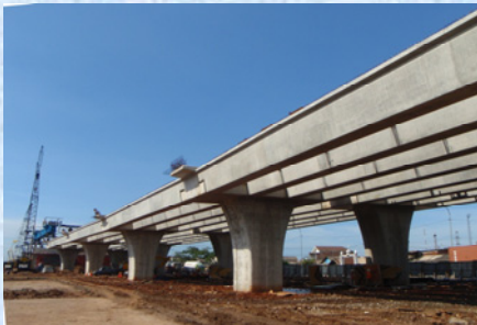
U桁架設完了
