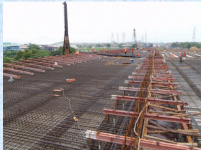
床版施工状況
