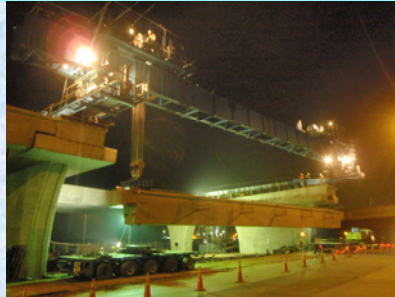
U桁夜間架設状況
