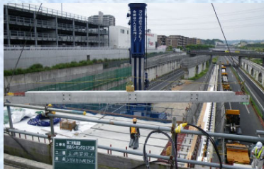
桁架設状況（側面）
