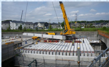
桁架設状況（横断面）
