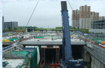
桁架設状況（側面）
