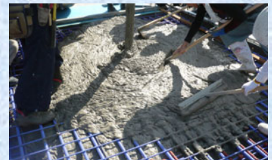
床版連結部打設
