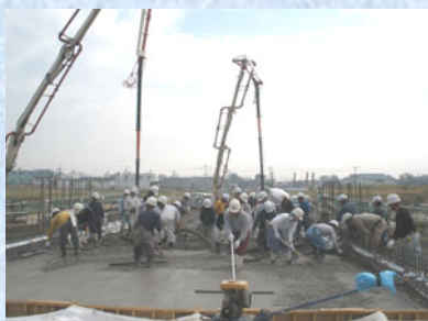
主版コンクリート打設
