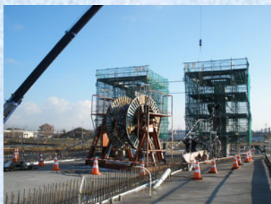
斜材架設状況
