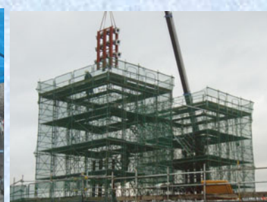
主塔サドル架設状況
