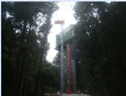
P 1 柱頭部施工状況
