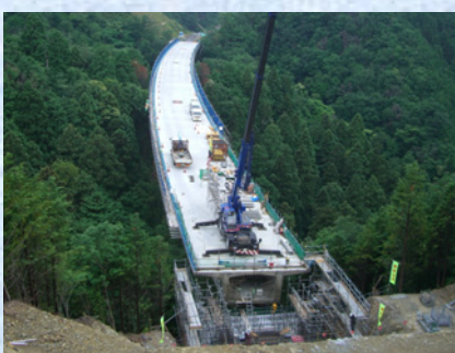
A1 橋台側径間施工
