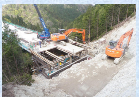
A1 橋台施工
