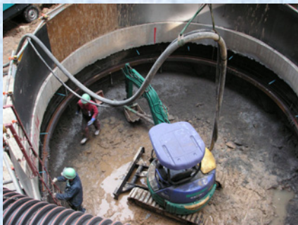
大口径深礎施工状況
