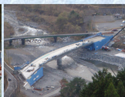
側径間支保工部施工
