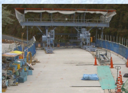
曲線桁張出し架設
