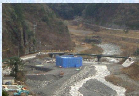
現橋と柱頭部施工状況
