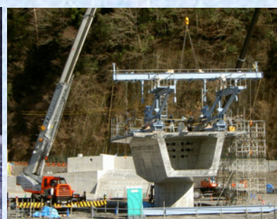
移動作業車組立状況
