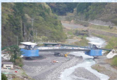
張出し架設状況
