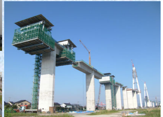
張出し架設全景及複合斜張橋施工
