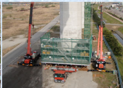
作業床横持ち移動
