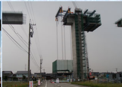
移動作業車組立状況
