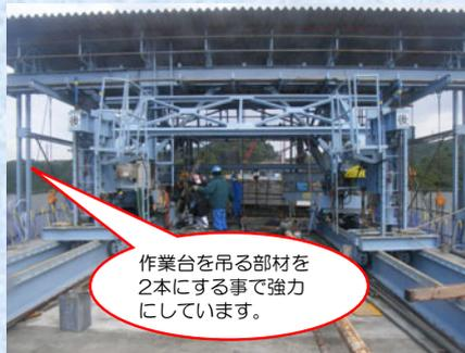
作業台を吊る部材を2本にする事で強力にしています。
