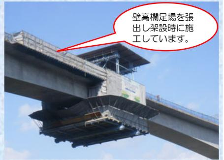
壁高欄足場を張出し架設時に施工しています。
