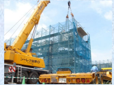
柱頭部セグメント吊込み
