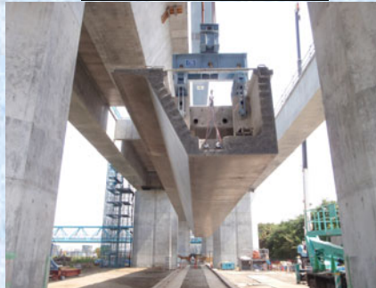
U桁リフティング
