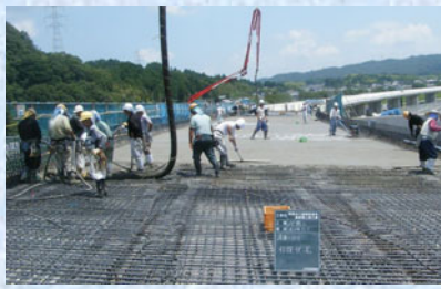
床版コンクリート打設
