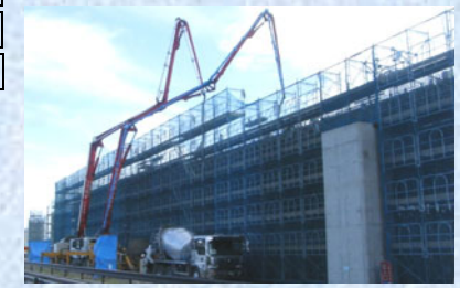
支保工・コンクリート打設
