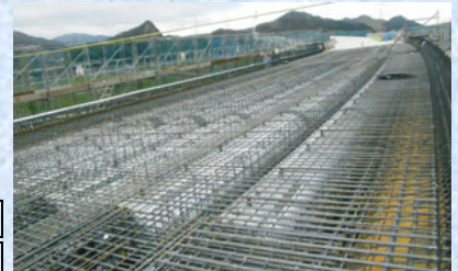
PC鉄筋組立
