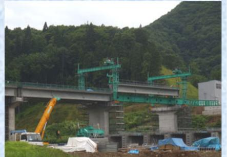
主桁架設桁架設
