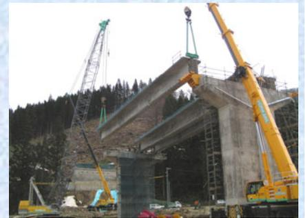
主桁クレーン架設
