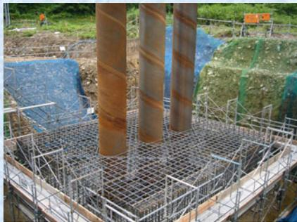
橋脚鋼管基礎建込み完了
