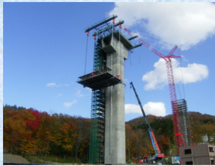
移動作業車組立状況
