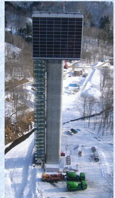
コンクリート打設状況
