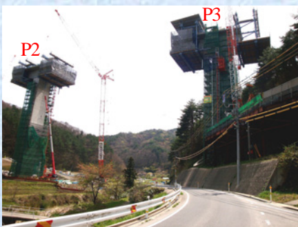
移動作業車県道上組立
