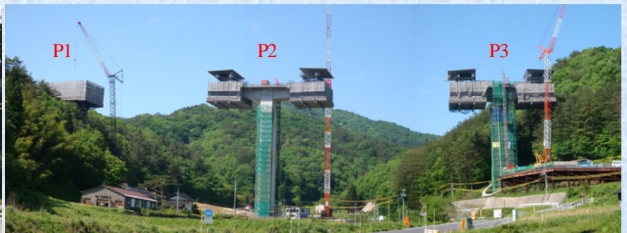
移動作業車4基稼働
