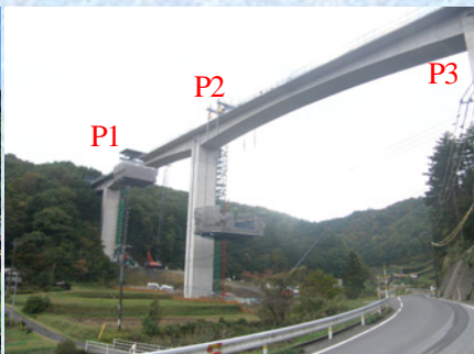
P3移動作業車 P2移動解体
