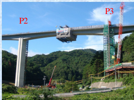
中央閉合部移動作業車使用
