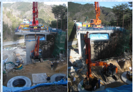
A1橋台施工上部工橋面使用
