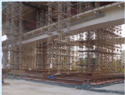
1,2次施工部支柱式支保工基礎
