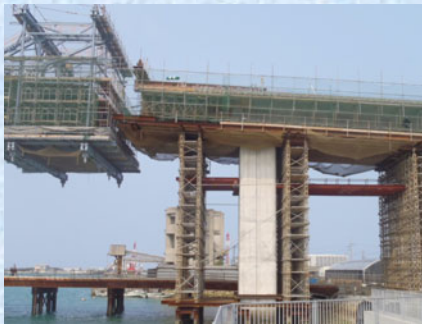
3次施工部吊り支保工架設
