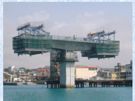
大型移動作業車張出し架設
