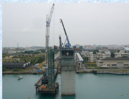
大型移動作業車組立
