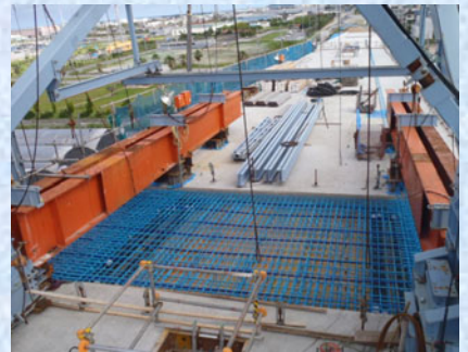
閉合部セッティング・ビーム架設状況
