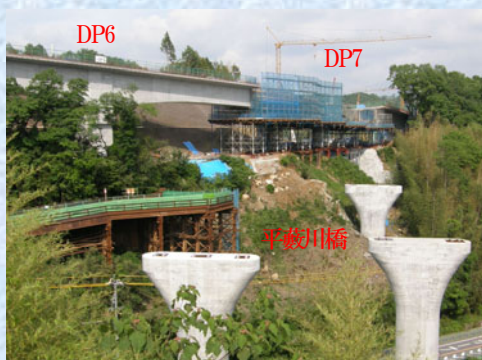
支保工施工状況
