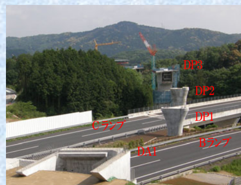
鋼桁架設予定交差部
