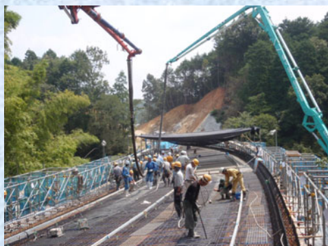
コンクリート打設
