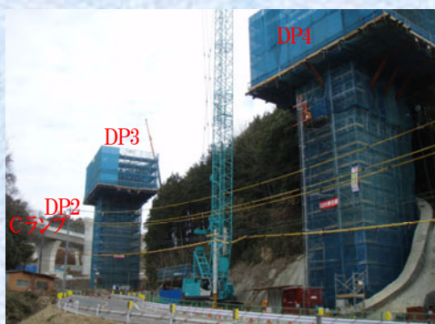
柱頭部施工状況
