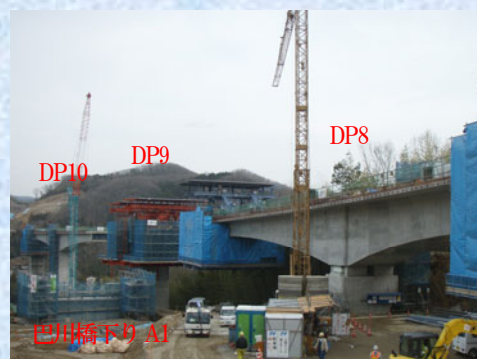
張出し架設状況
