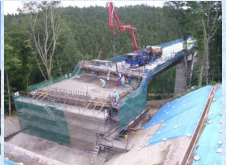
A2側径間支保工部施工
