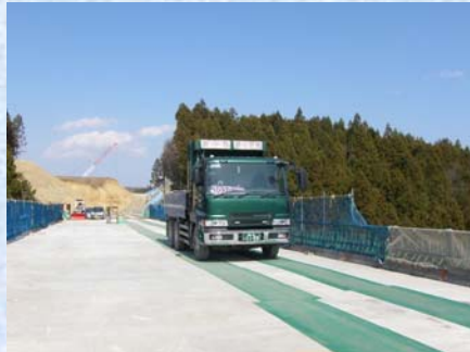
橋面からの土砂搬出
