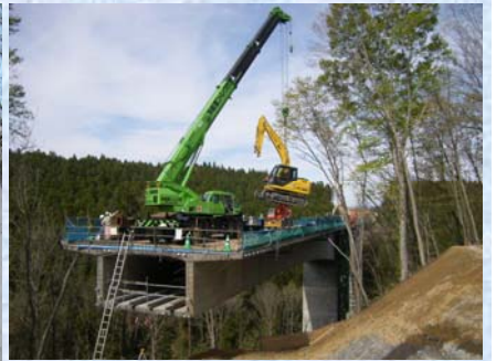
主桁上からの重機搬入
