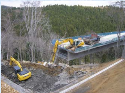
A2橋台掘削状況
