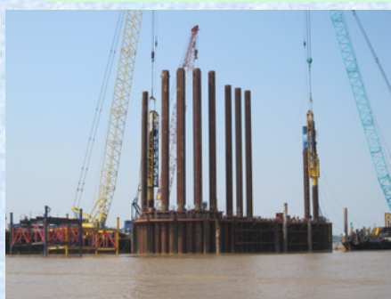
クレーンバージによる鋼管矢板の打設
