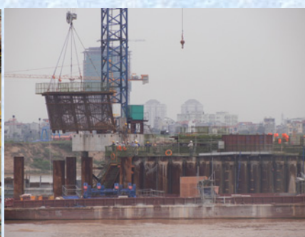
プレファブ鉄筋の設置
