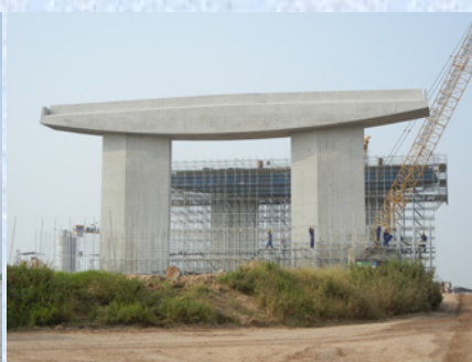
完成した取付橋下部工
