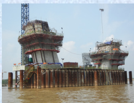
水上部の主塔の施工
