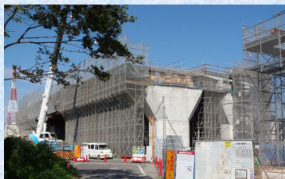
宮山高架橋 22 号橋
