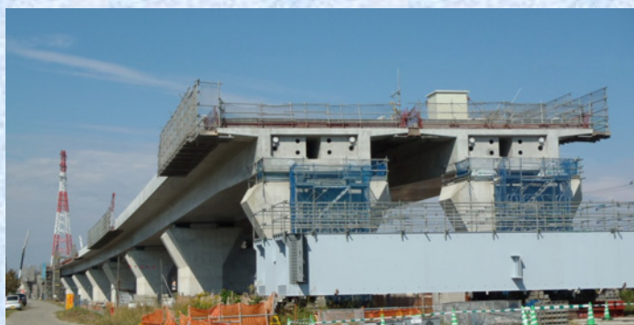
宮山高架橋 21 号橋
