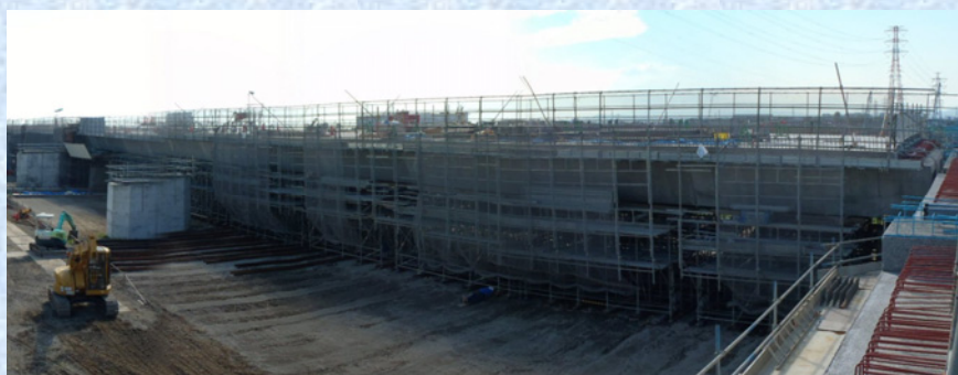
門沢橋第二高架橋
