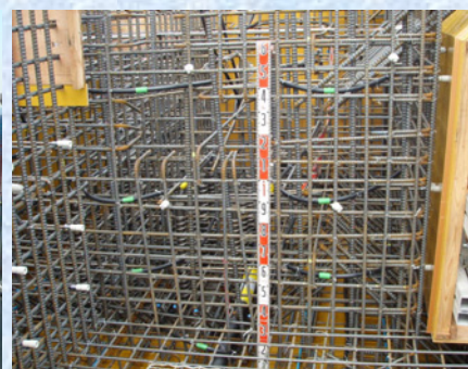
パイプクーリング状況
