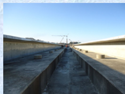
ホーム桁完成
