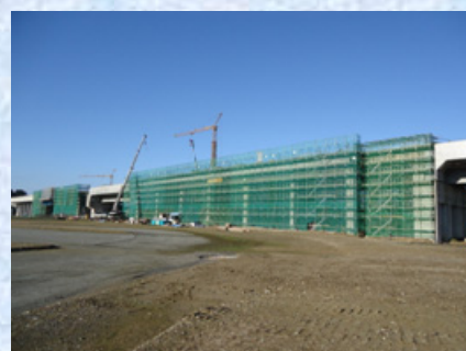
施工全景(写真左側ポタークレーン)
