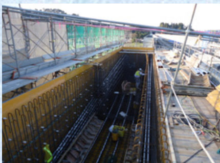
下床版ウェブ施工
