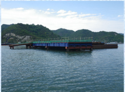
作業構台設置完了(P2)
