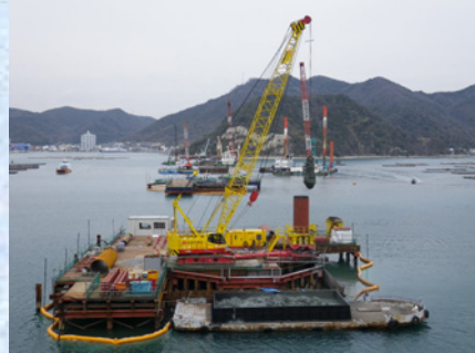
全旋回掘削状況(P5)
