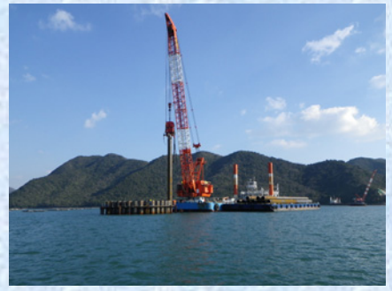
鋼管矢板打設状況(P2)
