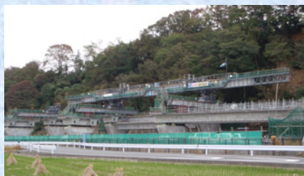
U桁部施工状況
