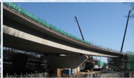
箱桁部施工状況
