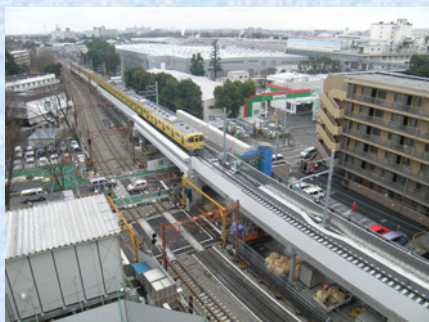
高架1次切替完了
