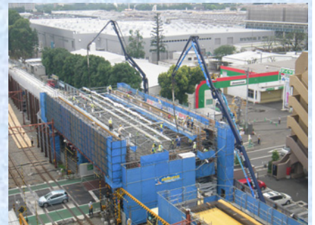
コンクリート打設
