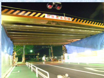
製作架台架設桁設置
