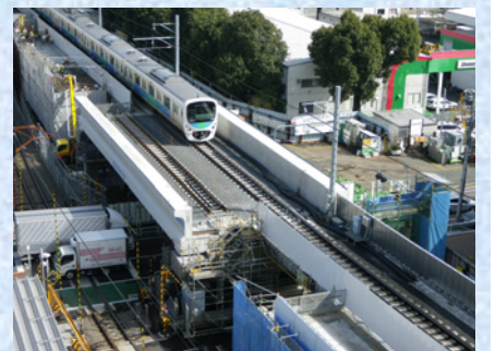
下路桁横移動完了
