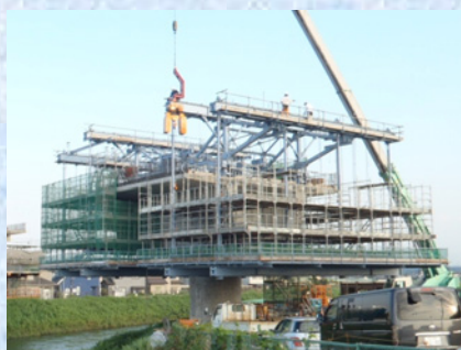
架設作業車組立
