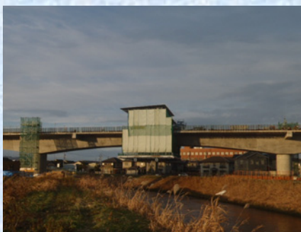
中央連結部施工
