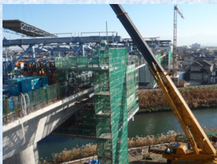
架設作業車後退解体
