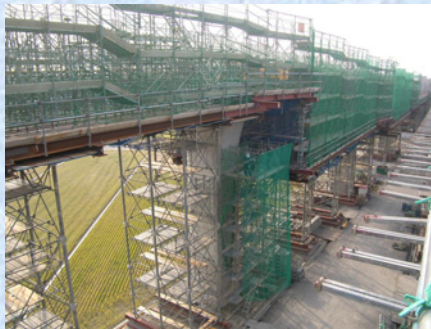
支保工組立(3次施工)
