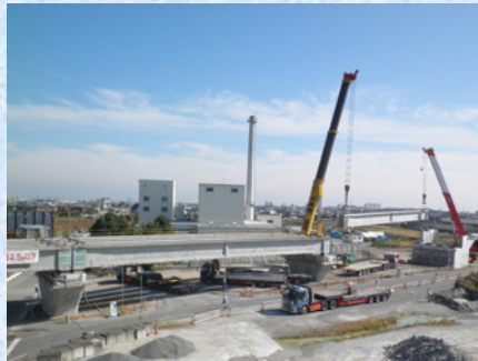
コンボ橋架設状況(宮ノ本橋)
