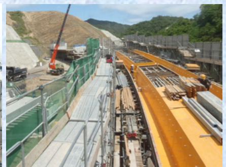
型枠組立(4次施工)
