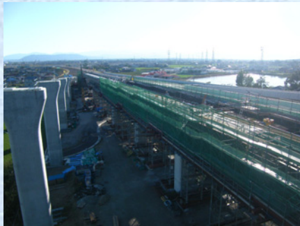
2主版桁橋架設状況(姫田Dランプ橋)
