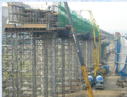
コンクリート打設(3次施工)
