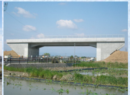
ポータルラーメン橋完成(大幸橋)
