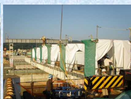
ブロック桁組立 PCケーブル挿入
