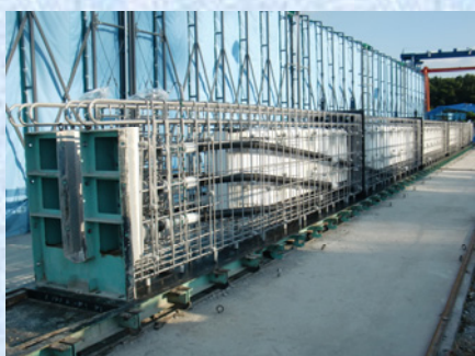
桁工場製作(ステンレス鉄筋使用)
