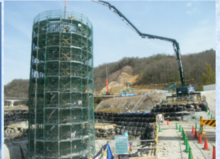
中詰めコンクリート打設
