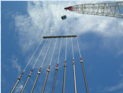
橋脚主筋建込み
