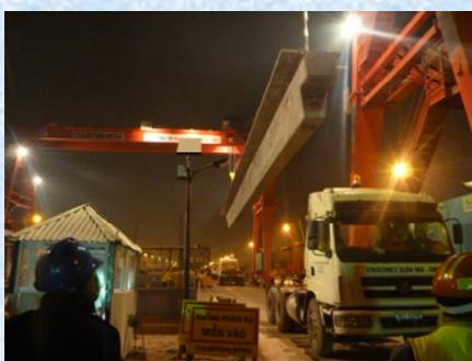
門型クレーン相吊りによる桁架設
